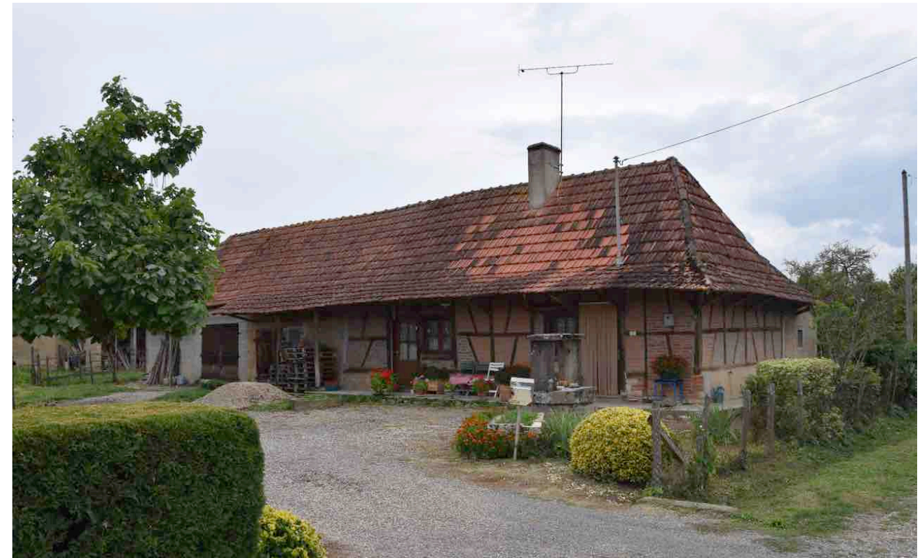
À gauche : Photographies Atelier du Triangle : ferme en pisé à Baudrières, ferme en briques à Rancy
